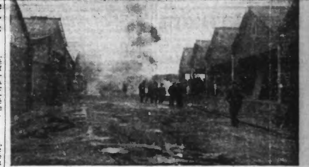
Un aspect de l'immense entrepôt dans lequel se déclara l'incendie. (Ph. Réveil)
