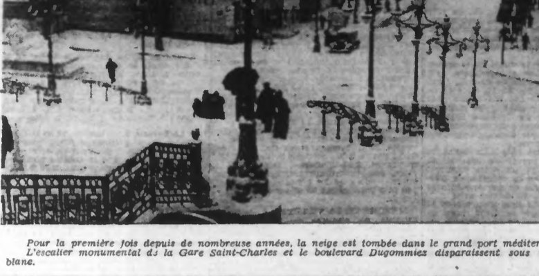
L'escaier monumental de la Gare Saint-Charles...
