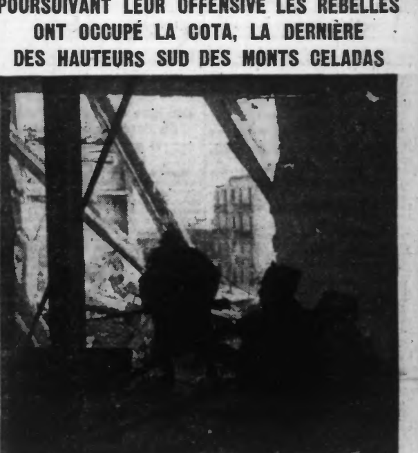
Bataille d'étage à étage dans les ruines de l'édifice du Gouvernement civil de TERUEL. Des miliciens se félicitent dans les décombres cherchant les fragments qui seraient cachés dans les ruines. C'est à la grenade que, ceux-ci ripostent aux attaques des miliciens. (Ph. Nyl)
