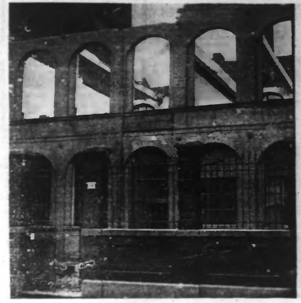
Parmi les vieilles écoles de Roubaix, celle de la rue Saint-Antoine, l'école Georges Sand avait la palme de l'ancienneté et elle fut désaffectée. Ces jours derniers, les démolisseurs ont pris possession de l'antique bâtisse, qui ne sera bientôt plus qu'un souvenir.
