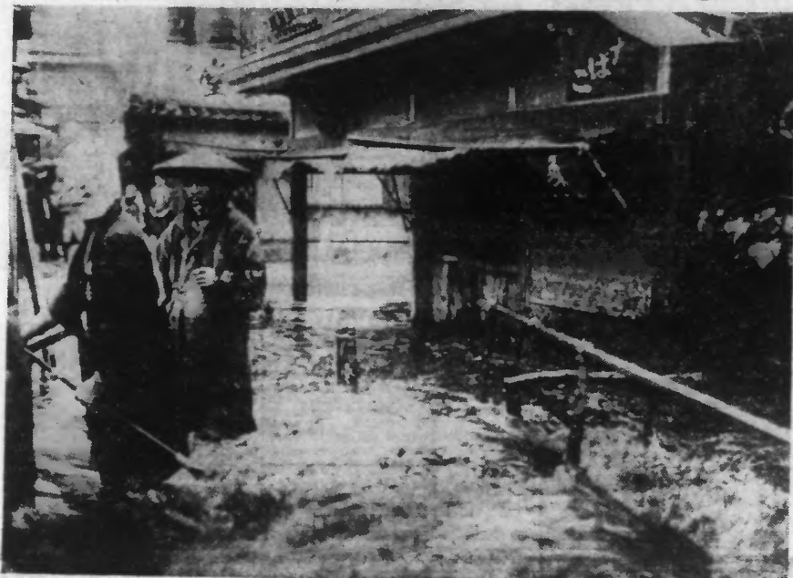
L'INONDATION DANS LES RUES DE TOKIO. (Photo Nyp)
