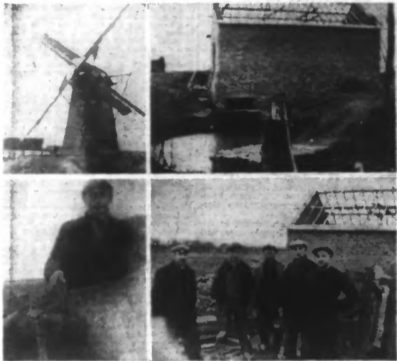
A gauche : Le moulin « Kerselaer », aux Moères, et en bas M. Damsen GERAERT, gardien du moulin. — A droite : La station de pompage mécanique en création à Ghysdele, et en bas, l'équipe d'ouvriers qui la construit. (Photo Réveil)
