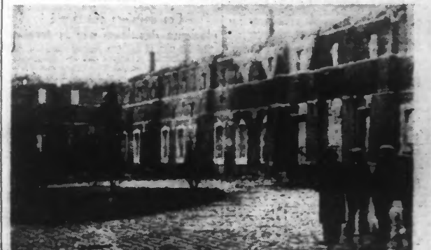
Les bâtiments sinistrés vus de la cour principale. (Ph. C. Duhamel)
