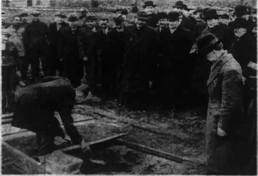
M. CARLES pose la première pierre du pavillon du Nord. (Ph. Réveil)
