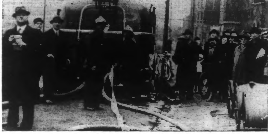
La nouvelle auto-pompe en fonctionnement sur la berge du Canal de Roubaix, au Quai du Sartel. (Ph. Egalité)
