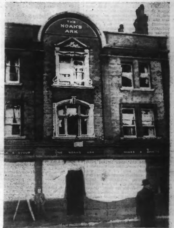
Les débris de l'explosion à Southwark, où de nombreuses vitres ont été brisées. (Ph. Keystone)
