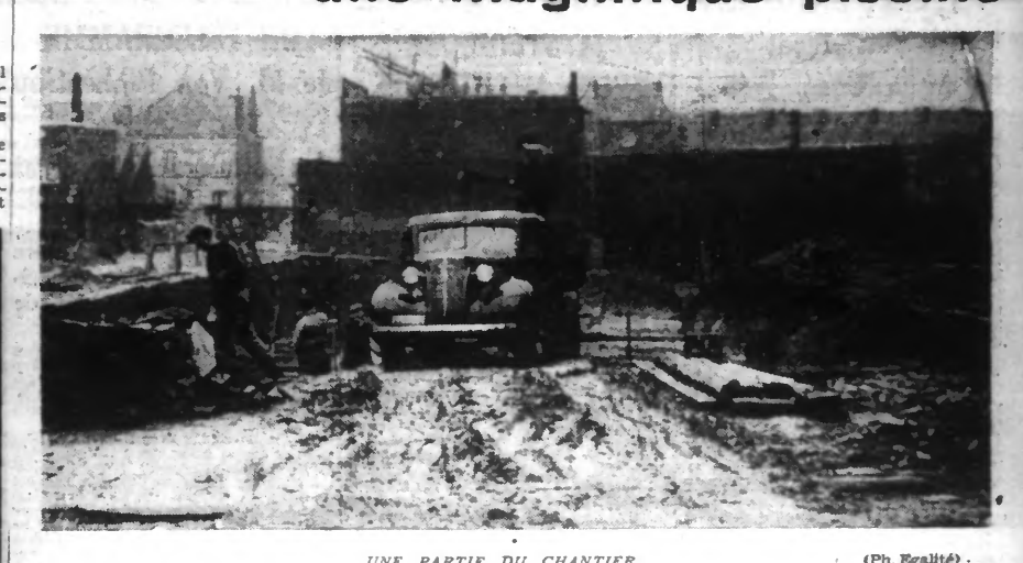
UNE PARTIE DU CHANTIER. (Ph. Egalité)
