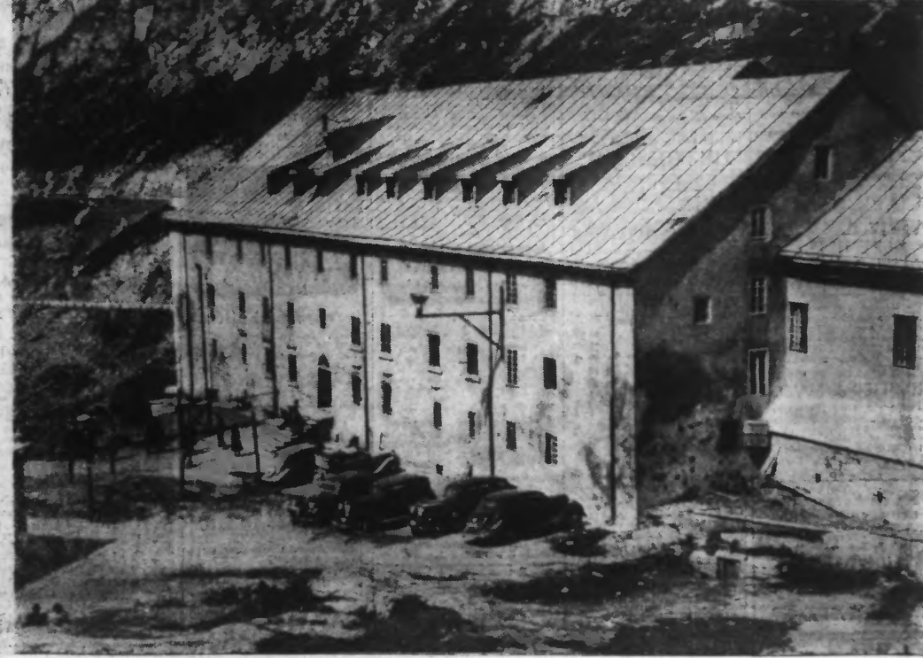
TEMPÊTE SUR LES ALPES. — La tempête a soufflé avec une telle violence sur les Alpes, que le toit de l'Hospice du Grand Saint-Bernard a été emporté pendant la nuit. La neige tombant à l'intérieur du bâtiment a atteint, le lendemain matin, un mètre d'épaisseur. Voici une vue de l'Hospice du Grand Saint-Bernard. (Photo N.Y.T.)
