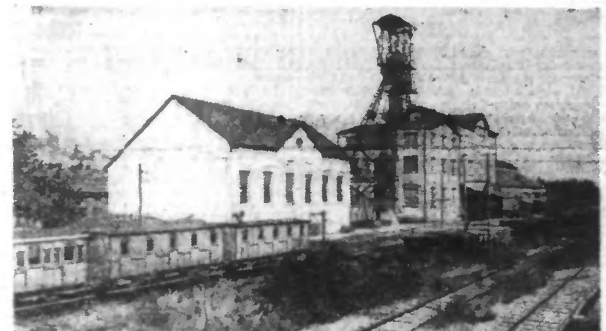
La Mine MAX à proximité de la station de LICHWILLER.
