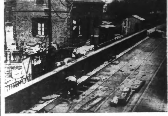
Comme nous l'avons annoncé, on a commencé la réparation du mécanisme du pont-tournoi du Blanc-Seau. De ce fait, la circulation va être interrompue pendant une période d'un mois 15 jours.
