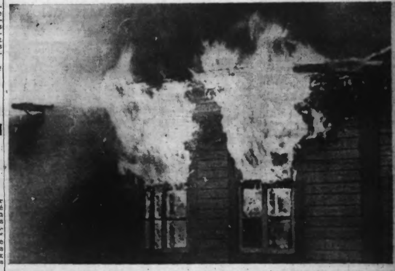
L'aviation soviétique continue avec un acharnement barbare, le bombardement des principaux centres finlandais. — Voici une maison de VIBORV anéantie par des bombes incendiaires. (Photo NYT. — A. 2.674).
