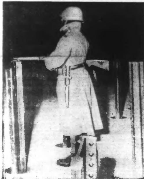
Une sentinelle montant la garde dans un barrage anti-tanks de la ligne de défense suisse « Guillaume Tell » (Photo Nyl - 87.060).
