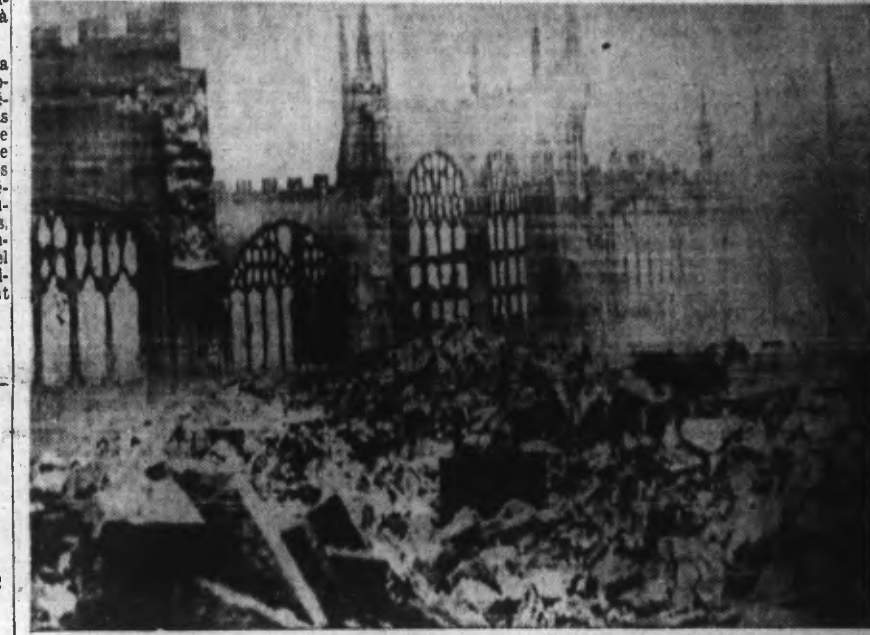
Dans un centre industriel de guerre à COVENTRY, une cathédrale complètement détruite par les bombes. (Ph. Siphon)
