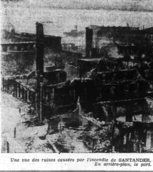
Une vue des ruines causées par l'incendie de SANTANDER, qui a mis 30.000 habitants sans abri. En arrière-plan, le port. (Ph. Graphopresse).
