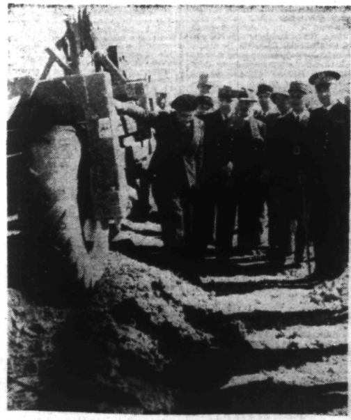
Le Résident général NOGUES et les Amiraux PLATON et ABRIAL inspectant les travaux du Transsaharien. (Ph. Siphon)
