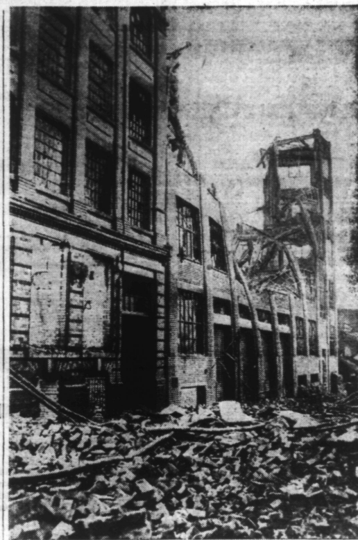
Devant une fabrique fortement endommagée, les débris jonchent le sol dans une rue de BIRMINGHAM, après un raid allemand. (Ph. Sado)
