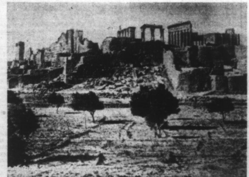
Vue des ruines de PALMYRE. (Ph. Belgapress)
