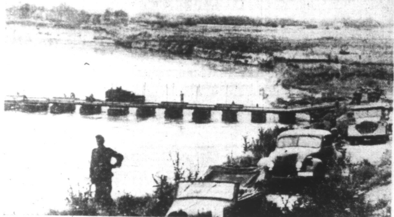
Pour la traversée du Pruth, par les unités motorisées allemandes, les pontonniers ont jeté ce pont capable de supporter 20 tonnes de charge, en un temps record. (Ph. Siphos)
