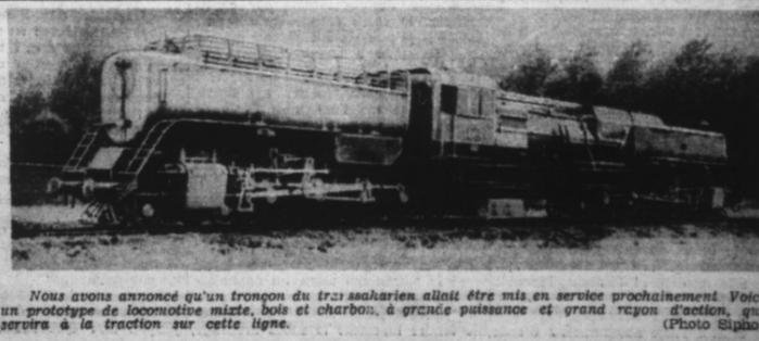
Nous avons annoncé qu'un tronçon du tracé saharien allait être mis en service prochainement. Voici un prototype de locomotive mixte, bois et charbon, à grande puissance et grand rayon d'action, qui servira de la traction sur cette ligne. (Photo Siph)
