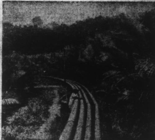
Une pipe-line conduisant le pétrole à travers la forêt vers un port pétrolier de BORNEO.
