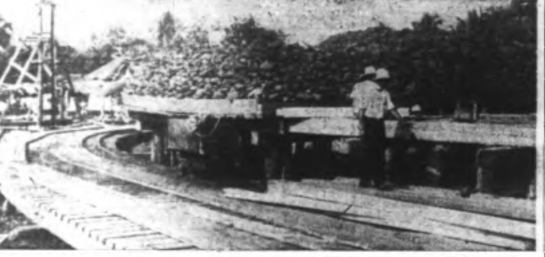
On procède au chargement du chrome, sur la côte de Zamboanga, au nord-est de MANILLE (Ph. Siph)
