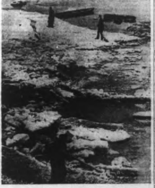
Sur le front Est, pour débarrasser le fleuve des glaçons, on casse quelque peu les blocs avec de longs pieux ; les mines sous-marines feront le reste. (Ph. Sado).
