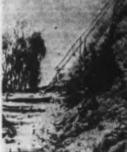
Travaux d'approche dans les environs du fort de BALAKLAWA. (Ph. Graphopresse).
