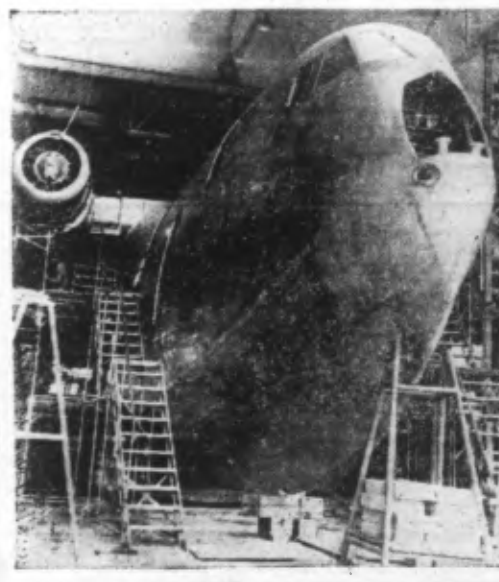
L'achèvement à MARIGNANE, de la construction de l'hydravion de S.E. 200, appareil de grand rayon d'action, de 70 tonnes, enter-gare, 52 m. ; longueur de la coque, 40 m. ; puissance, 9.600 CV. ; 24 heures de vol avec un équipage de 8 hommes et 40 passagers en couchettes ou 78 assis.
