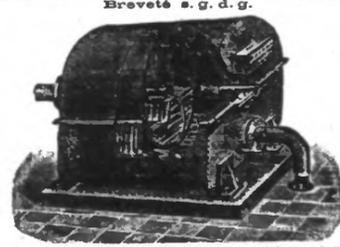
Pour mesurer le volume des liquides et spécialement de l'eau employée à l'alimentation des chaudières. Exactitude garantie, l'appareil se comportant ni soupapes ni organes ou vants se déréglent. L'emploi de l'appareil permet le contrôle de la qualité du charbon et de l'état de la chaudière, ainsi que de l'habileté du chauffeur, etc. Provisé sur demande. — Appareil à l'essai.
