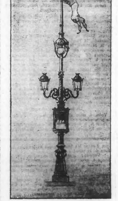
UN PYLON D'ÉCLAIRAGE
