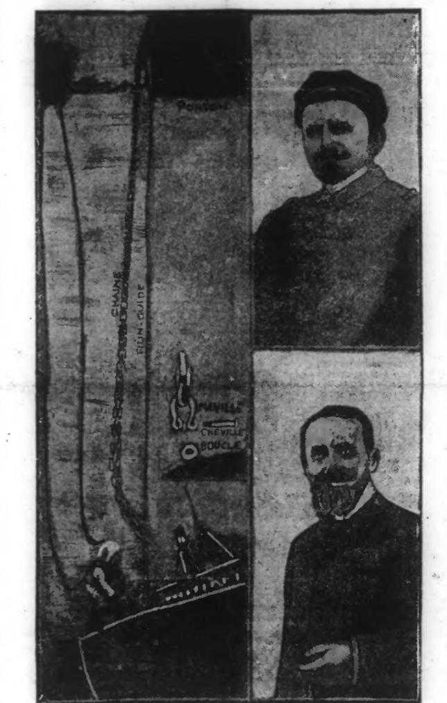
L'AMARRAGE DES BOUCLES pour le renforcement. Les scaphandriers, étant arrivés à l'épave, attachent autour des boucles un filin-guidé descendu du pont; l'œil de la boucle reste ainsi dégagé; on fait alors glisser le long du filin, une chaîne, dont l'extrémité est maillée à la boucle, au moyen d'une manivelle et d'une cheville. (D'après l'Illustration)
