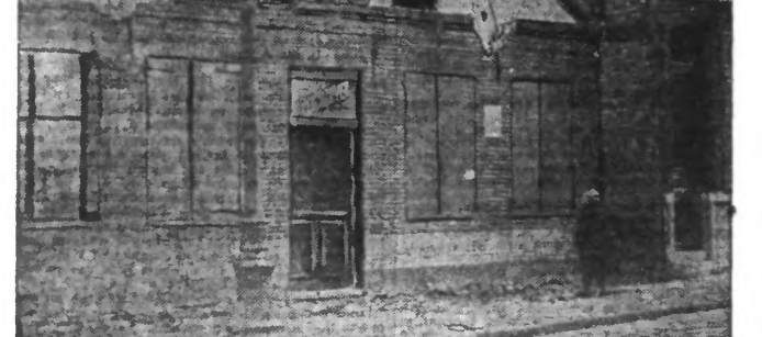
LA « MAISON DU SORCIER », RUE DU MOULIN
