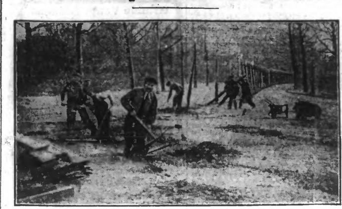
L'enlèvement des palissades, avenue Le Nôtre. Ainsi que nous l'avons annoncé, c'est vendredi qu'ont commencé les travaux d'enlèvement des palissades de l'Exposition, avenue Le Nôtre.
