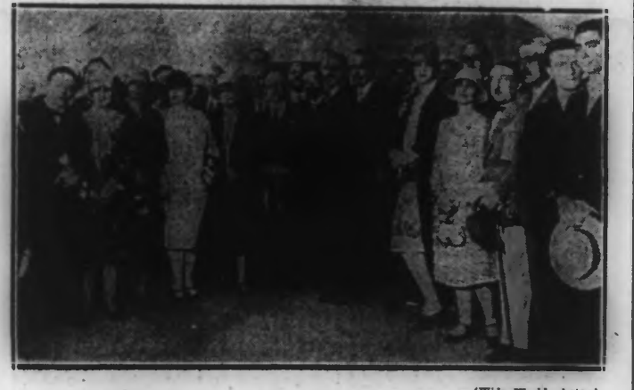
LES CONGRESSISTES VISITANT LE NOUVEAU PALAIS DE LA PRESSE, EN CONSTRUCTION
