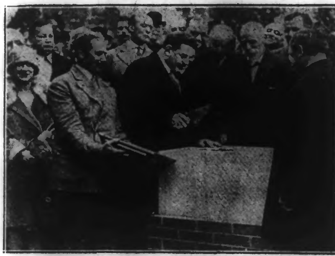
M. Edouard Herriot, ministre de l'Instruction publique, a posé la première pierre de la Maison de la Chimie, qui s'élèvera sur l'emplacement des anciens phares du Trocadéro.
