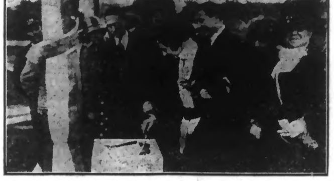
M lle WINBURN SCILLE LA PREMIÈRE PIERRE DE LA FONDATION Grâce à la générosité de M lle Winburn, Américaine bien connue pour ses dons philanthropiques, on a procédé à la pose de la première pierre d'une fondation qui portera le nom de la généreuse donatrice. Cette fondation, qui se trouve à Courbevoie, servira d'hôpital et de pouponnière pour les bébés et enfants français. M. Désiré Ferry, ministre de la Santé publique, a présidé la pose de la première pierre.
