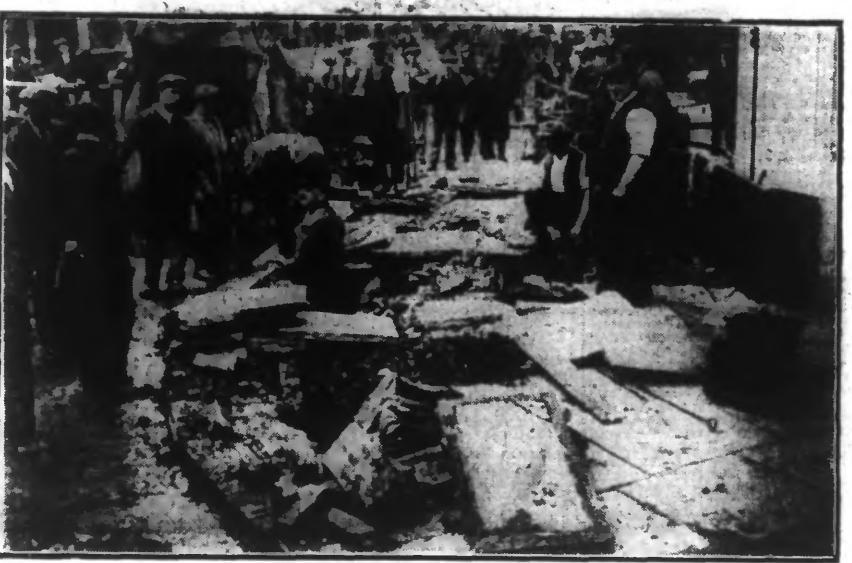
Tout une rue saisissante des dégâts causés dans une rue de Londres par le tremblement de terre qui a créé une coulée d'eau et bouleversé la chaussée. La panique a été des plus vives dans ce quartier populaire. (Ph. Kerstone.)
