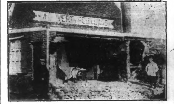
LES EFFETS DE L'EXPLOSION : LE MUR DE LA CUISINE A CÉDÉ SOUS LA POUSSEE DE LA DÉFLAGRATION
