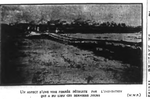
UN ASPECT D'UNE VOIE FERRÉE DÉTRUITE PAR L'INONDATION QUI A EU LIEU CES DERNIERS JOURS (W.W.P.)
