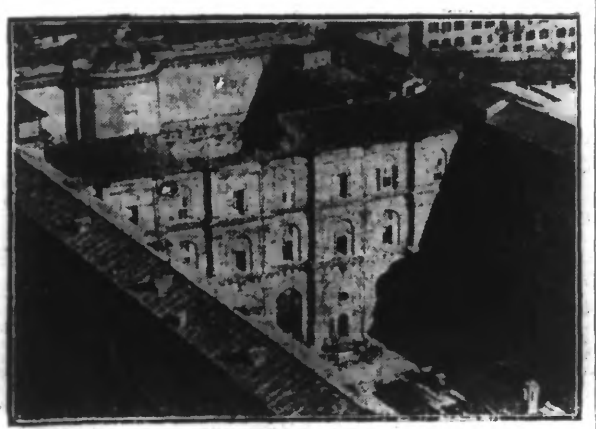
UNE VUE DU BATIMENT AVEC LA TOITURE EFONDURÉE. On voit que trois plafonds de la Bibliothèque vaticane se sont effondrés à 3 h. 45, le 27 décembre.
