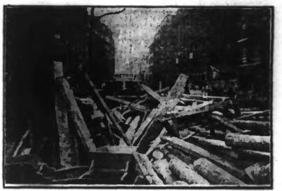
C'EST SIMPLEMENT UNE PLACE DE PARIS TRANSFORMÉE EN CHANTIER
