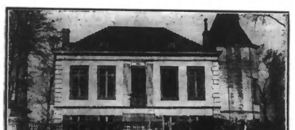
L'ÉCOLE DE GARÇONS DE LA MARLIÈRE QUI DEVIENDRA L'ÉCOLE MATERNELLE
