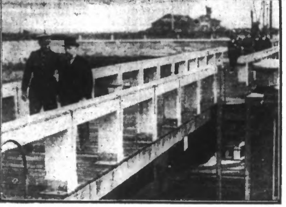
Le Roi Albert s'est rendu à Anvers où, sous la conduite du bourgmestre, M. Van Cauwelaert, il a visité le port et particulièrement le gigantesque travail de percement du tunnel sous l'Escaut. VOICI LE ROI DES BELGES, CONDUIT PAR M. VAN CAUWELAERT, PHOTOGRAPHIÉ AU COURS DE SA VISITE. (Photo Keystone.)
