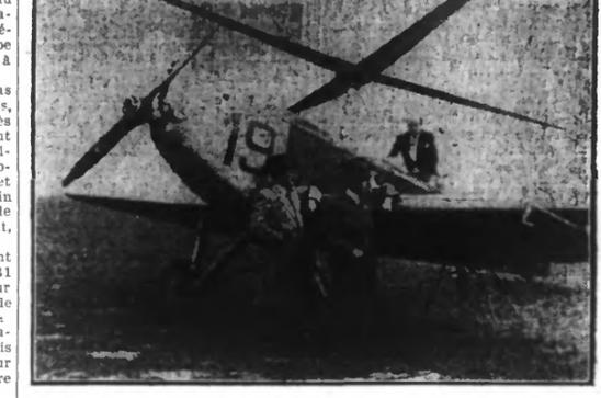
A Guyancourt (Seine-et-Oise), deux inventeurs français, MM. Odier et Dessire, ont mis au point un dispositif rappelant celui qui est employé sur les autogyres, mais pouvant s'adapter sur tous les avions à ailes surbaissées. Cet appareil peut atterrir sous un angle de 45°
