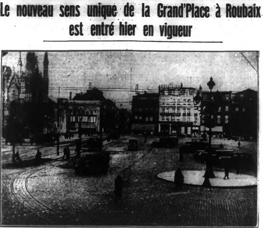
UNE VUE DE LA GRAND-PLACE. Une des principales dispositions du nouveau sens unique consiste à faire passer le long du refuge bordant les lignes de tramways les autos venant de la Grand-Rue.
