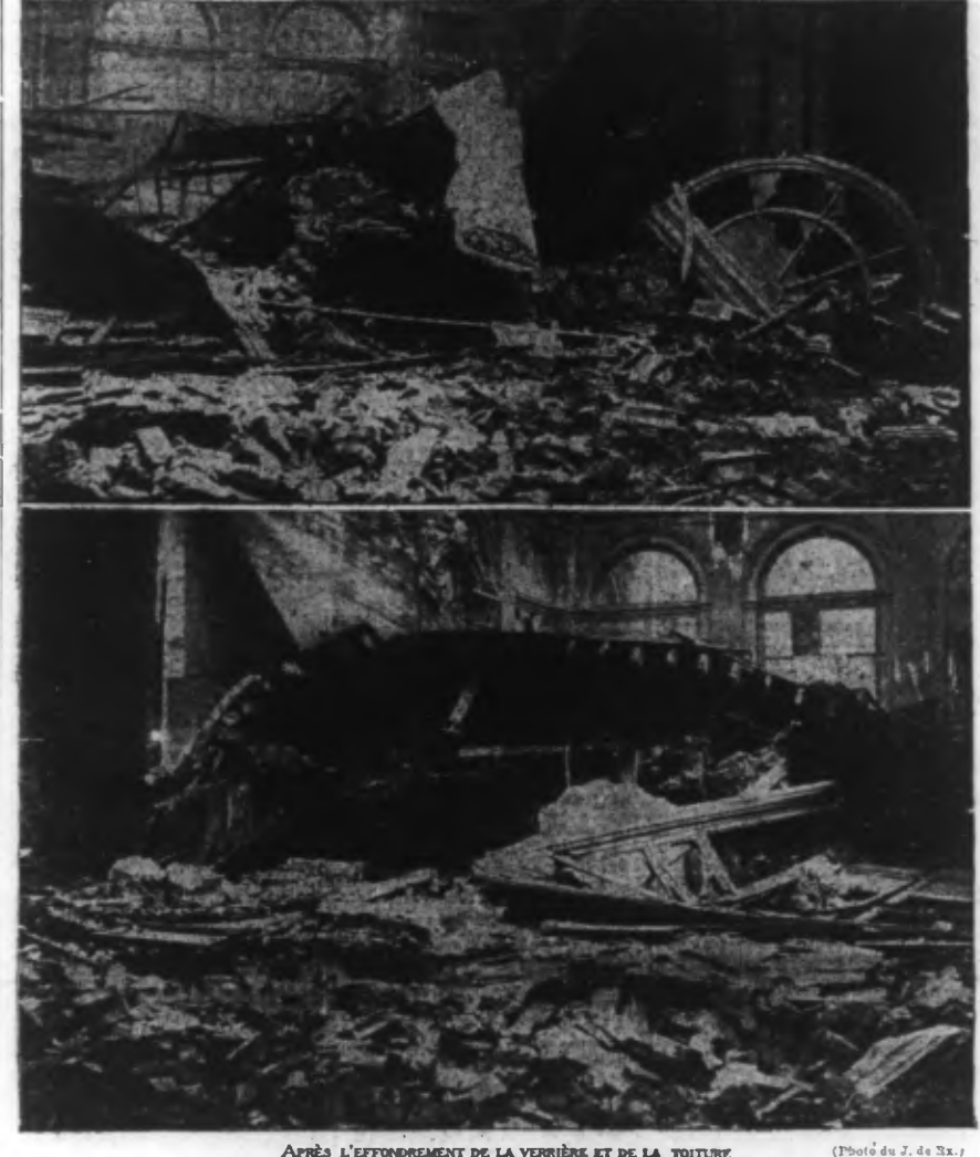
APRÈS L'EFFONDREMENT DE LA VERRIÈRE ET DE LA TOITURE (Photo du J. de Roubaix)
