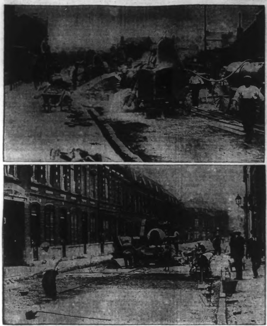
En haut: Une bétonnière en action, rue Gouand. En bas: Rue du Fresnoy, des ouvriers étalent une couche de béton, avant qu'on ne procède au pavage.
