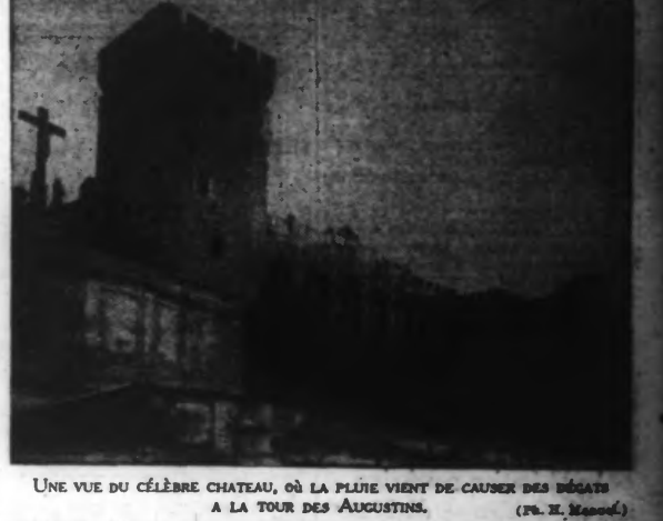
UNE VUE DU CÉLÈBRE CHATEAU, OÙ LA PLUIE VIENT DE CAUSER DES DÉGÂTS A LA TOUR DES AUGUSTINS. (Ph. H. Massot.)
