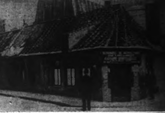
Les travaux de démolition de l'ancien cabaret de la Planche Trouvée ont commencé mardi.
