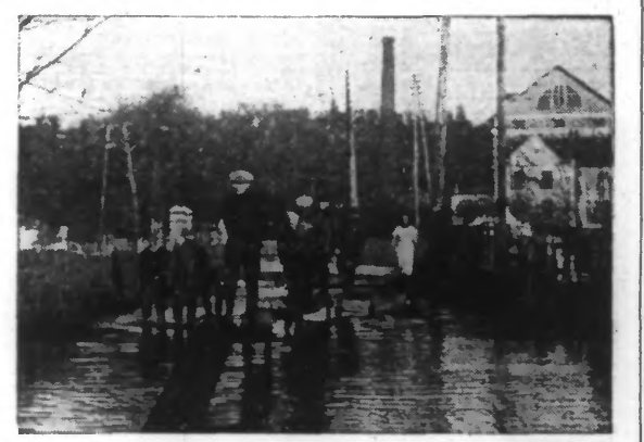
DES PASSERELLES SONT INSTALLÉES DANS LES RUES DE VILLENEUVE-SAINTE-GEORGES, POUR LA CIRCULATION DES PIÉTONS.
